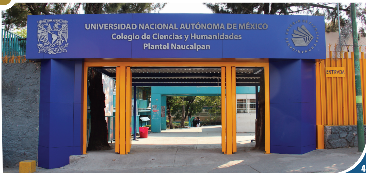
Remodelación de la Entrada principal del Plantel.
