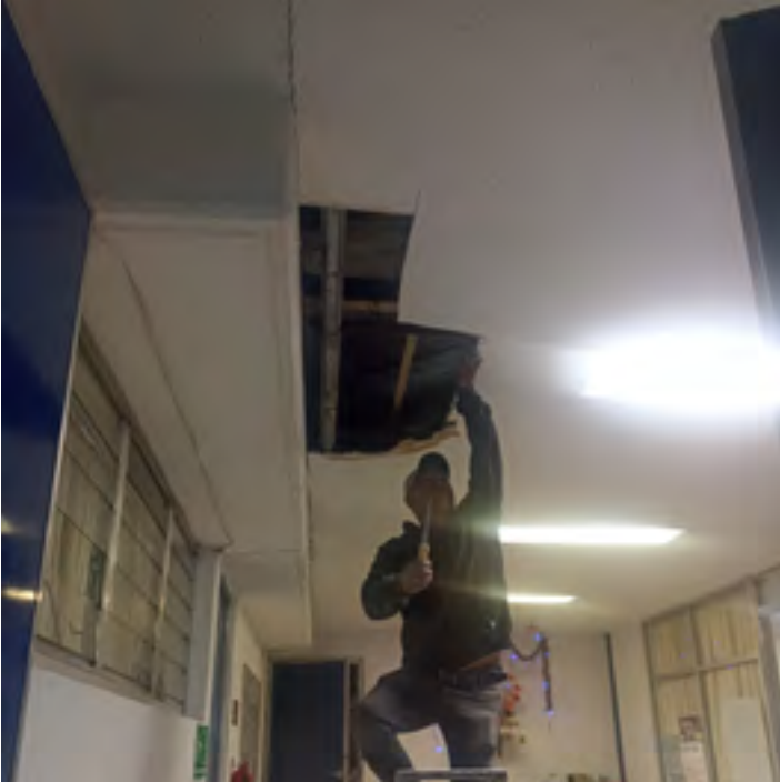
30. Rehabilitación de muro en sala de conferencias y filtraciones en losa maciza de sanitarios de profesoras en edificio de Audiovisual.
