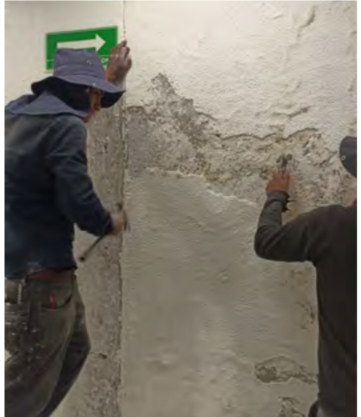
30. Rehabilitación de muro en sala de conferencias y filtraciones en losa maciza de sanitarios de profesoras en edificio de Audiovisual.
