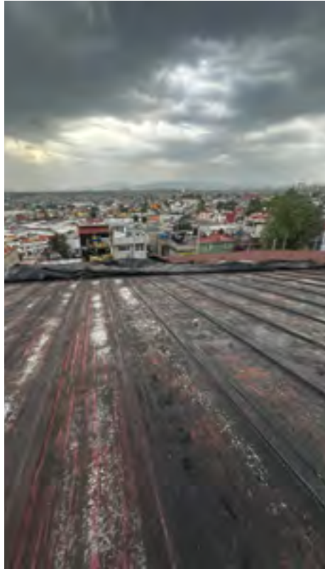
19. Desmantelamiento de membrana impermeable prefabricada en edificio de biblioteca CCH Naucalpan: 100 m 2 totales: 100% trabajo terminado.
