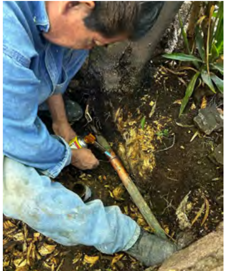
24. Reparación de fuga de agua en cabecera del edificio U.
