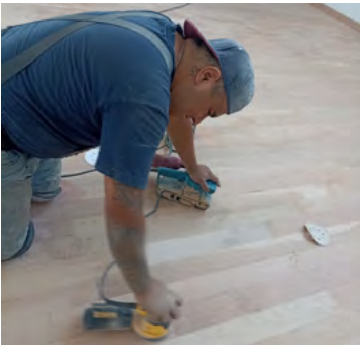
25. Renovación de la Sala de Danza: incluye cambio de duela de madera, retiro y cambio de espejos, alisamiento y pintura nueva en paredes y cubierta, sellado y retiro de ductería de aire acondicionado, colocación de piso de cerámica debajo de la duela de madera.
