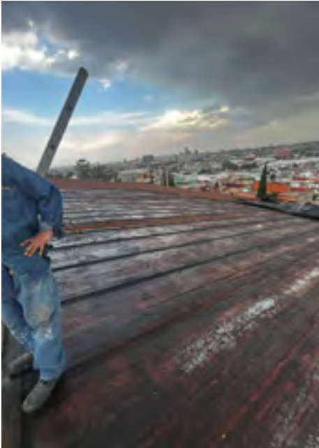
19. Desmantelamiento de membrana impermeable prefabricada en edificio de biblioteca CCH Naucalpan: 100 m 2 totales: 100% trabajo terminado.
