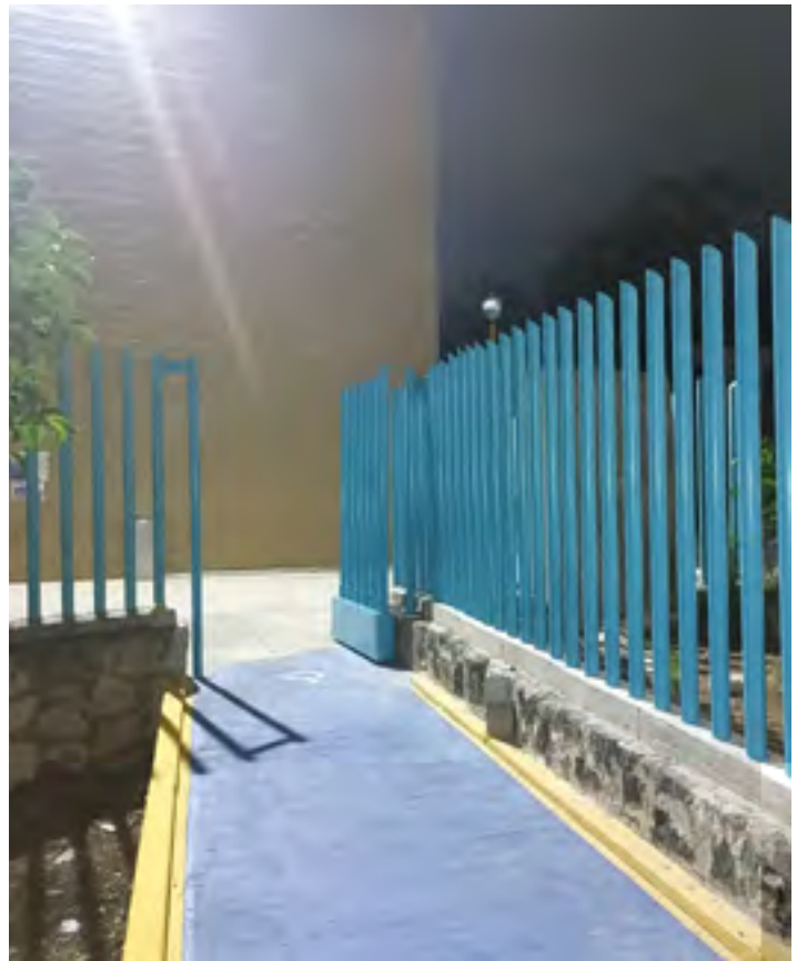
28. Puerta de acero a base de tubos cédula 30 de 3" de diámetro en acceso a Siladín.
