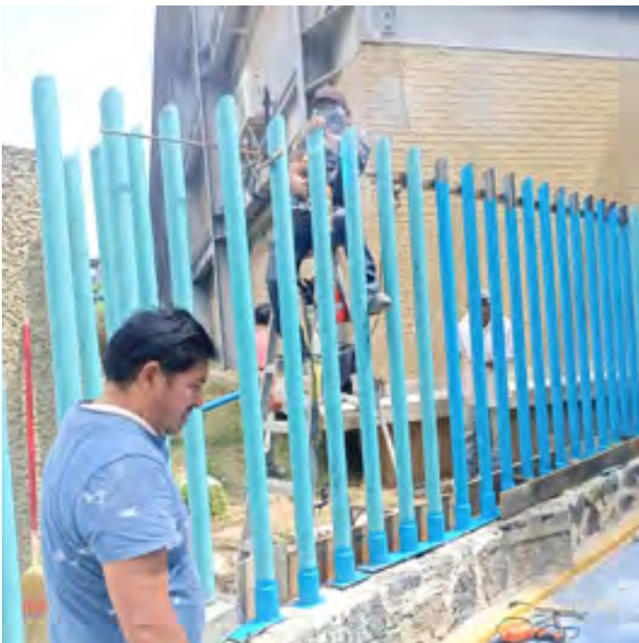
28. Puerta de acero a base de tubos cédula 30 de 3" de diámetro en acceso a Siladín.
