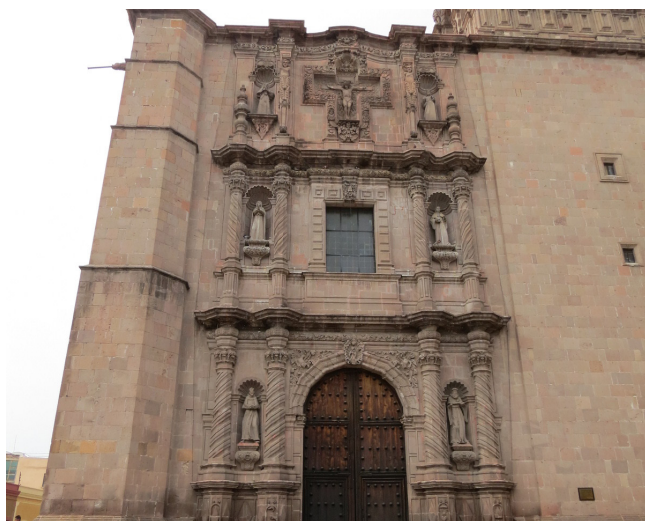
Fachada principal de la iglesia del Conjunto conventual de San Agustín.
