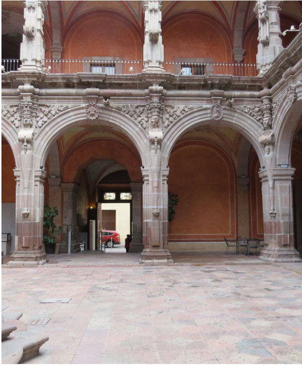
Entrada principal del ex Convento, al fondo.
